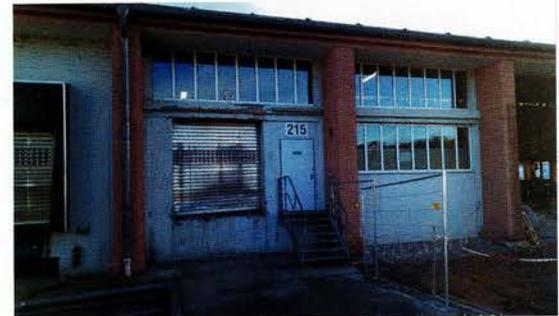
01 Die vorhandenen tragenden Stützelemente der Außenwand basieren auf einem Rastermaß, das ideal ist für den Einbau der Verladestellen
