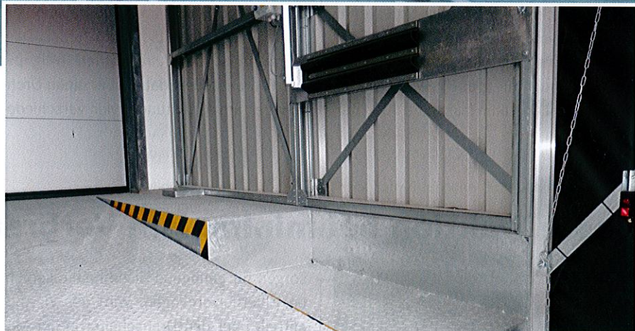
Loadhouse mit Stufenrampe.
