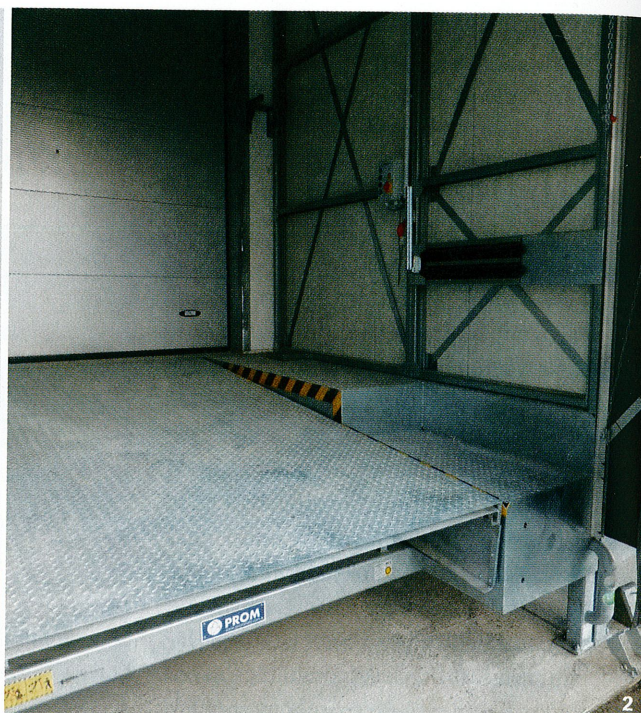
1 Die Verladestelle für besonders niedrige Lkw in der neuen Geschäftsstelle von DB Schenker in Nürnberg. 2 Die Stufenrampe gestattet das Andocken der unterschiedlichsten Lkw-Typen. Dabei wird das Plateau von einem elektrohydraulischen Steuermechanismus in der Höhe gehalten, um die Fahrzeuge nicht übermäßig zu belasten. 3 Während des Verladevorganges sind Mensch und Ware komplett wettergeschützt – zur Freude des zuständigen Personals.
