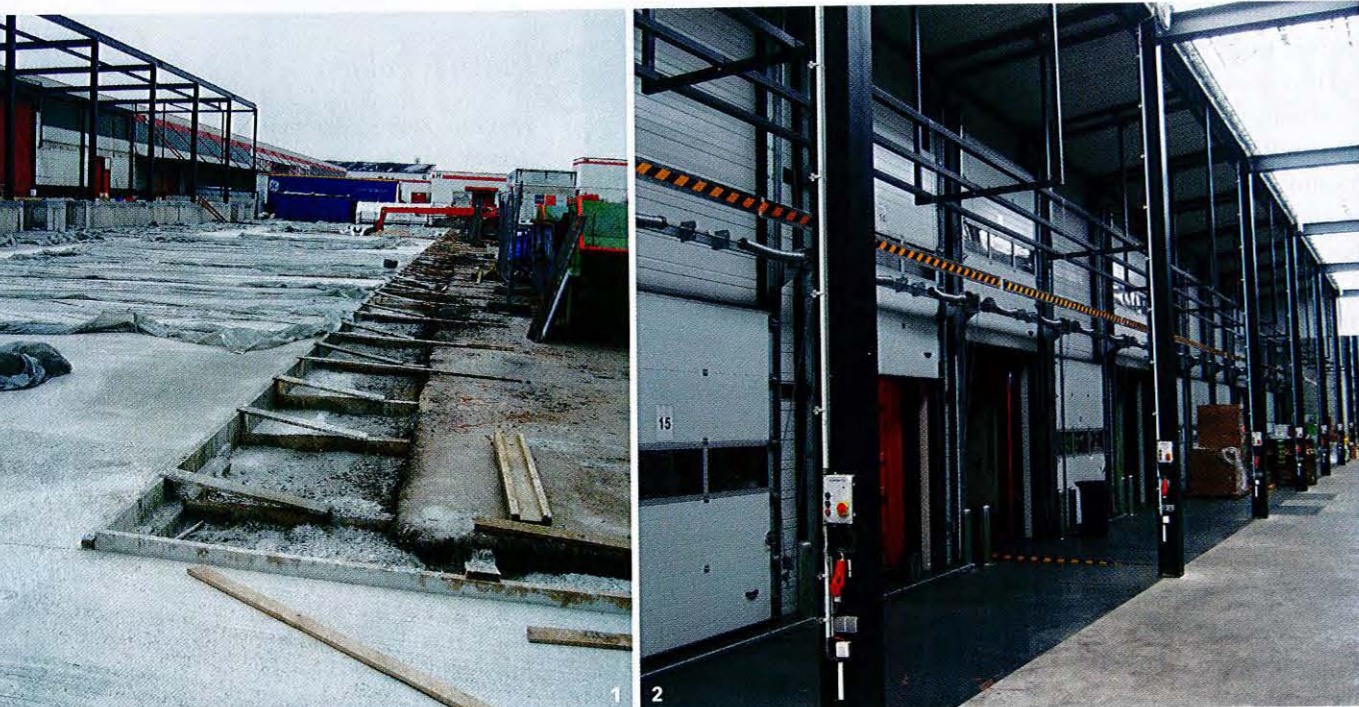
1 Erhebliche Baumaßnahmen waren erforderlich, um die Verladezone des Logistikers F. W. Neukirch in Bremen auf Vordermann zu bringen. 2 Neu, effektiv und großzügig: die innere Verladezone mit einem Platzgewinn von 300 Quadratmetern. 3 Istzustand: modernes Erscheinungsbild für ein modernes Unternehmen.
